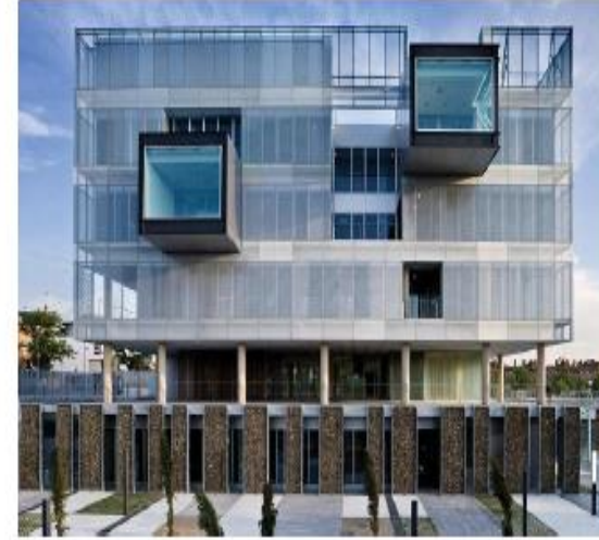
الواجهة المزدوجة الصندوقية في مبنى الشرطة الجديد بمدريد
