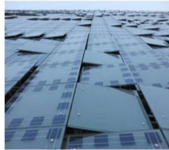
واجهة مبنى Greenpix واستخدام الخلايا الشمسية فيها
