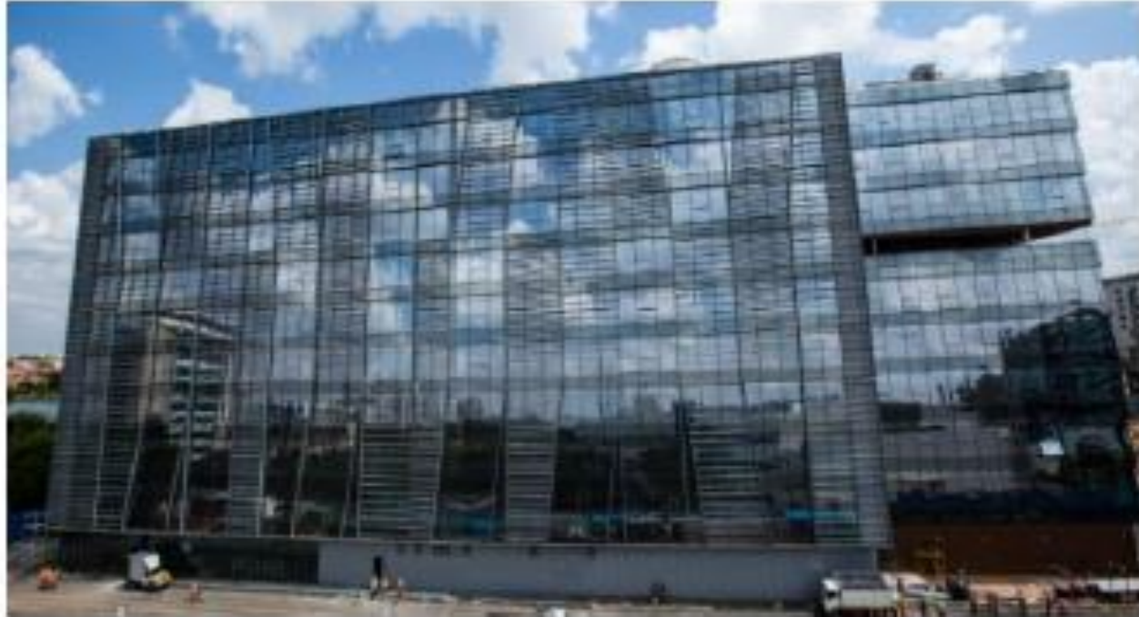
مبنى Intel Mobile Communication India - الهند
